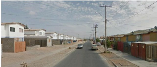
Figura 83 Vista Sector 3 Villa Vista Alegre
