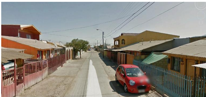
Figura 68 Vista Sector 1 Villa El Edén.
