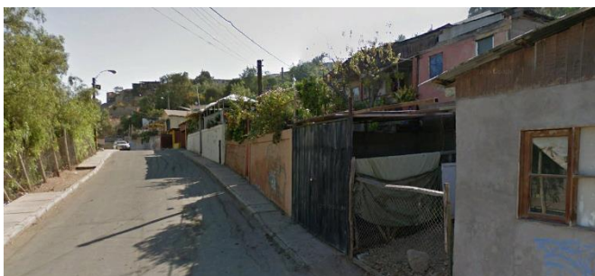
Figura 71 Vista Villa Antena.
